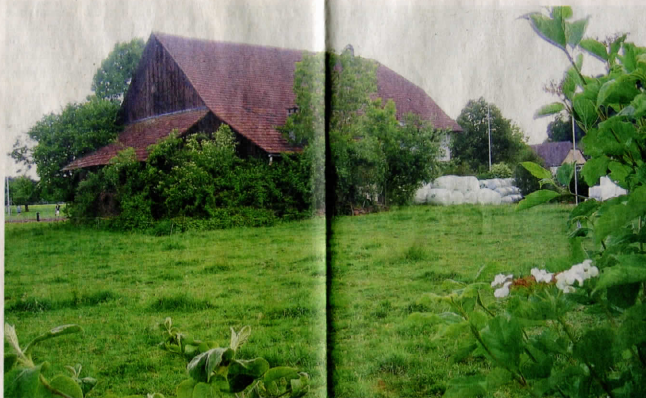
Der Gemeinderat beantragt den Rückbau des alten, baufälligen Karl-Wernli-Hauses.
