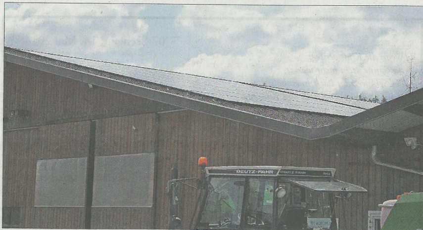
Strom vom Landwirtschaftsgebäude.
